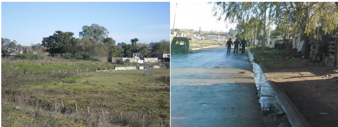
Izq. Cancha Albion anegada en forma temporal; Der.: Conducción de pluviales y efluentes domésticos
