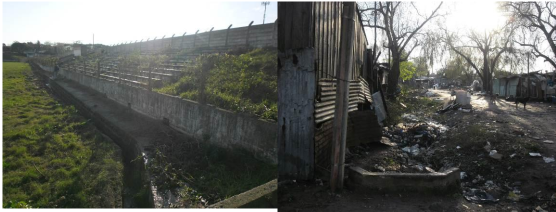
Izq. Pluviales cancha Huracán Buceo y área donde queda anegada en forma temporal; Der.: Cuneta con dirección a Larravide. Conduce pluviales y efluentes doméstico
