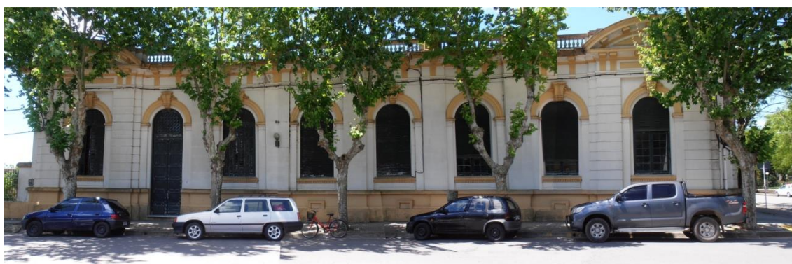
FACHADA SOBRE CALLE SARANDÍ
