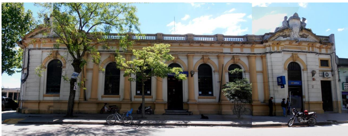
FACHADA SOBRE CALLE EAST SOSA BERNADET
