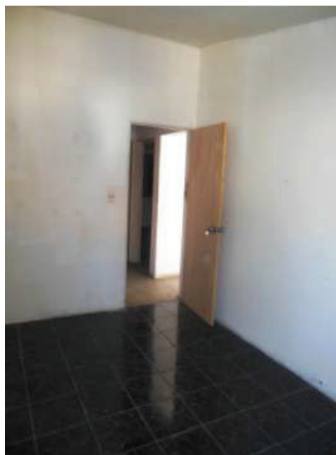
ID. 109063- 20190719 - foto 6. Dormitorio del frente
