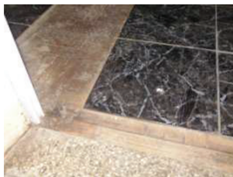
ID. 109063- 20190719 - foto 12. Pasillo-Dormitorio fondo.
