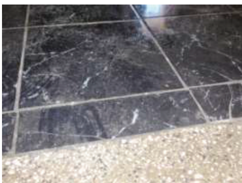
ID. 109063- 20190719 - foto 11. Pasillo-Dormitorio frente.
