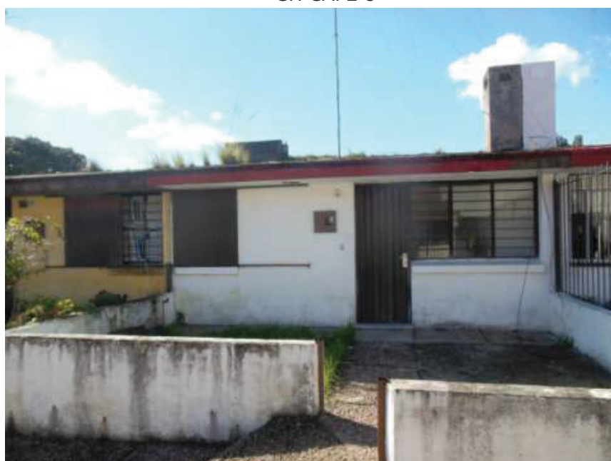
ID. 109063- 20190719 - foto 2. Fachada unidad 002.
