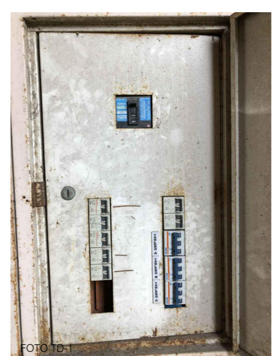
RELEVAMIENTO FOTOGRÁFICO Esc -
